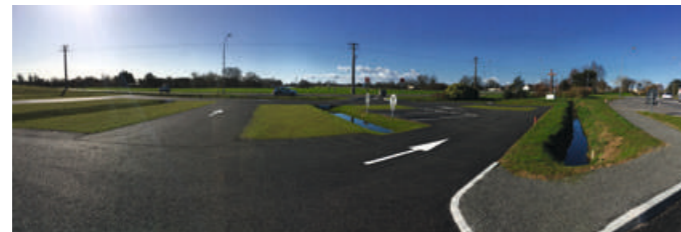
Aire de covoiturage du Moulin Mocrat à Machecoul, stationnement en terre-pierre enherbé incluant des noues pour la gestion hydraulique du site. Source : Marc Letourneux
