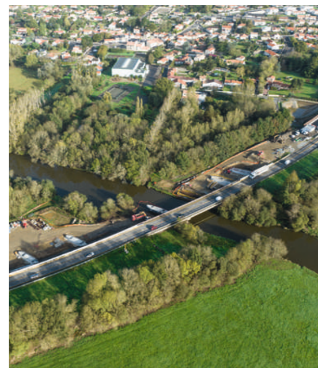
Travaux de doublement de la déviation de Port-Saint-Père/ Auteurs de Vues. Source : F. Henry
