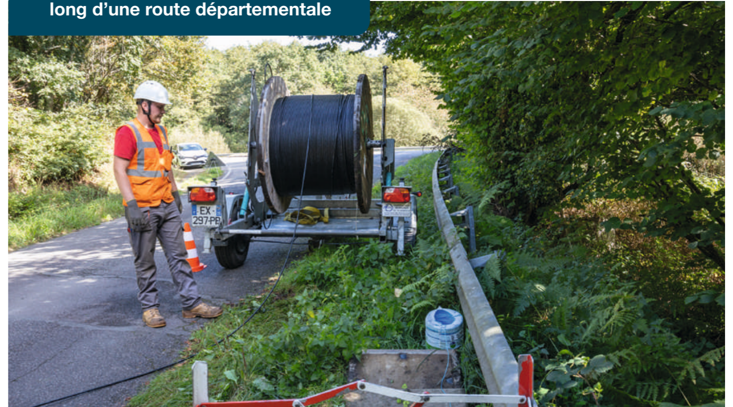
Travaux pour la fibre à Vigneux-de-Bretagne. Source : Paul Pascal / Département de Loire-Atlantique
