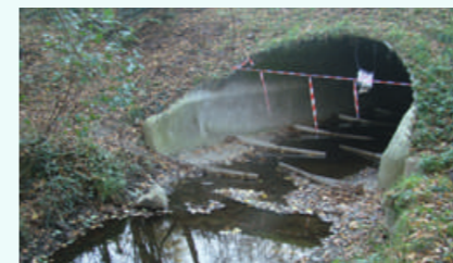
Pont du Gueubert à Vallet avec aménagements de déflecteurs et de seuils pour passe à poissons. Source : Nicolas Boudot / Département de Loire-Atlantique
