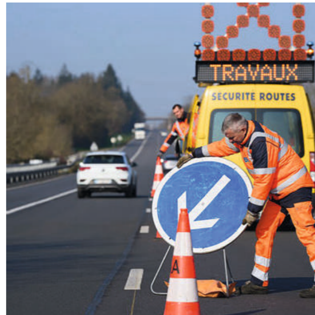
Agents d'exploitation des routes en intervention. Source : Gaël Arnaud / Département de Loire-Atlantique
