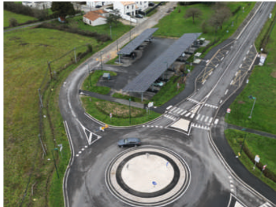
Ombrières photovoltaïques sur parking en bordure de RD 723 à Rouans. Source : SEM Enr 44
