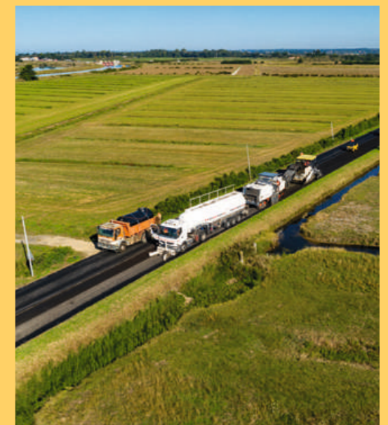
Réfection de chaussée sur la RD 758 à Villeneuve-en-Retz, réutilisation des enrobés en place et intégration d'un liant biosourcé. Source : Paul Pascal / Département de Loire-Atlantique
